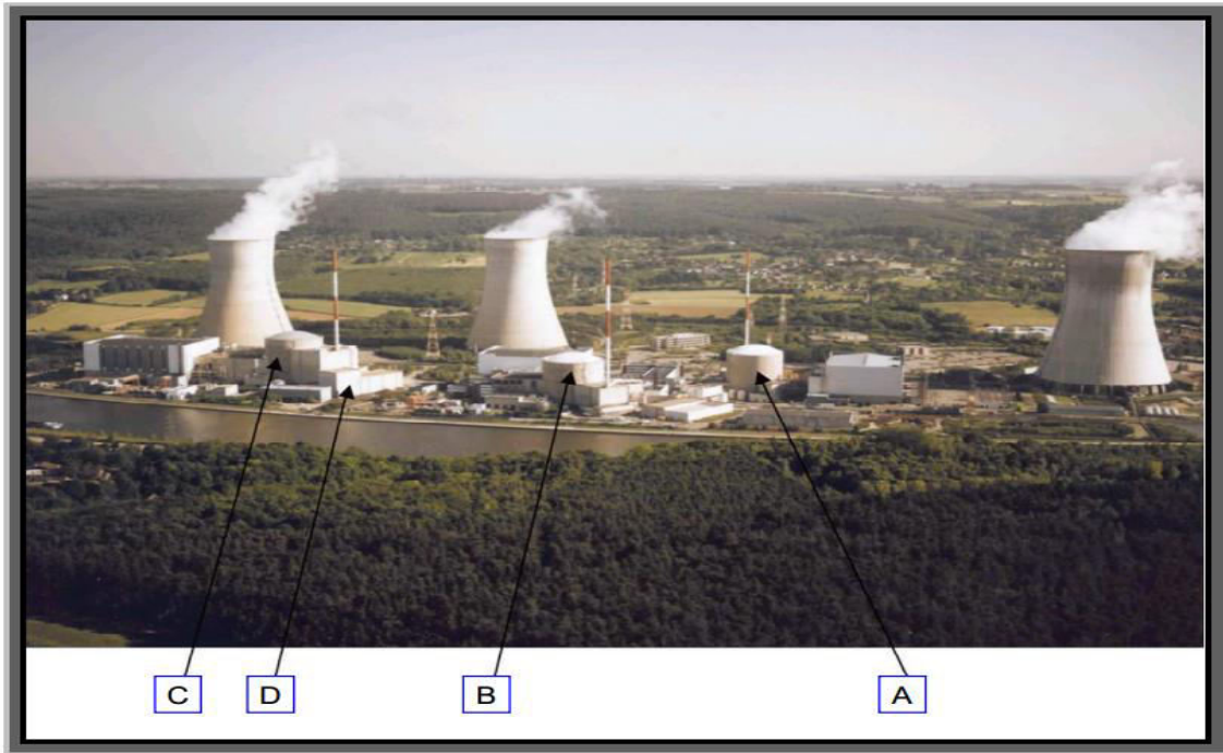
Bild 1: Anordnung der AKW Blöcke am Standort Tihange (A: Tihange 1, B: Tihange 2, C: Tihange 3, D: Nasslager für abgebrannte Brennelemente) /2/
